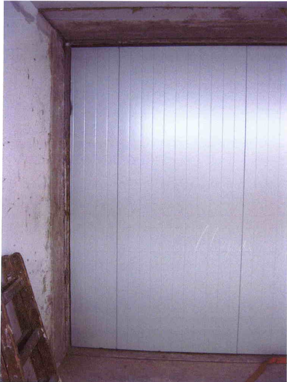
Abbildung 1: Gesamtaufbau der geprüften Wand aus Sandwichelementen, Ansicht Senderaum
