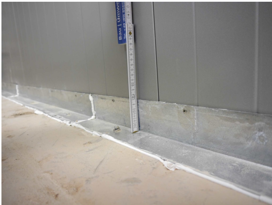
Abbildung 4. Anschluss des Prüfobjektes an den Prüfstand mit Stahlwinkeln, sende- raumseitig (exemplarische Abbildung).
