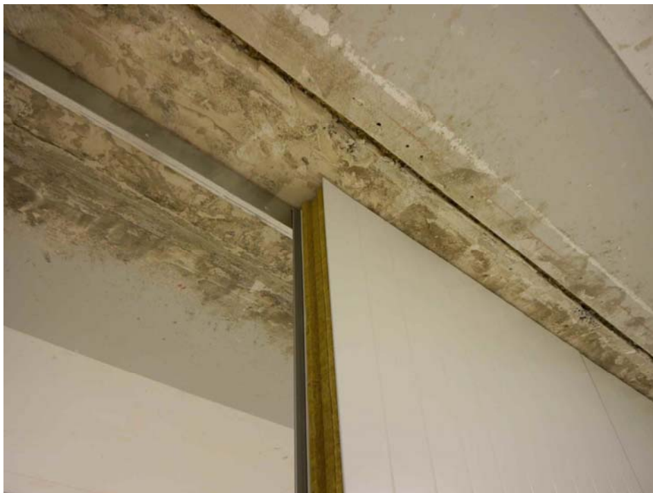
Abbildung 2. Montage der Mineralwollpaneele in den Wandprüfstand (exemplarische Abbildung).
