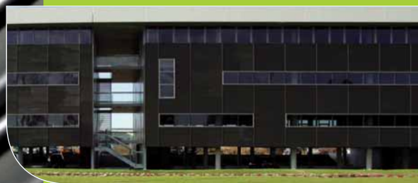
BUREAUX DU TASTA (33) - Architectes : Luc Arsène Henry Jr & A. Triaud.
