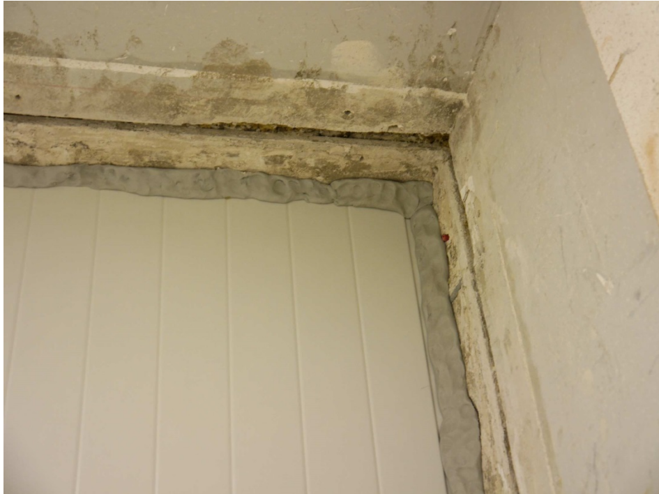
Abbildung 3. Abdichtung der Anschlussfugen zwischen Prüfobjekt und Prüfstand mit dauerplastischer Dichtmasse, empfangsraumseitig (exemplarische Abbildung).
