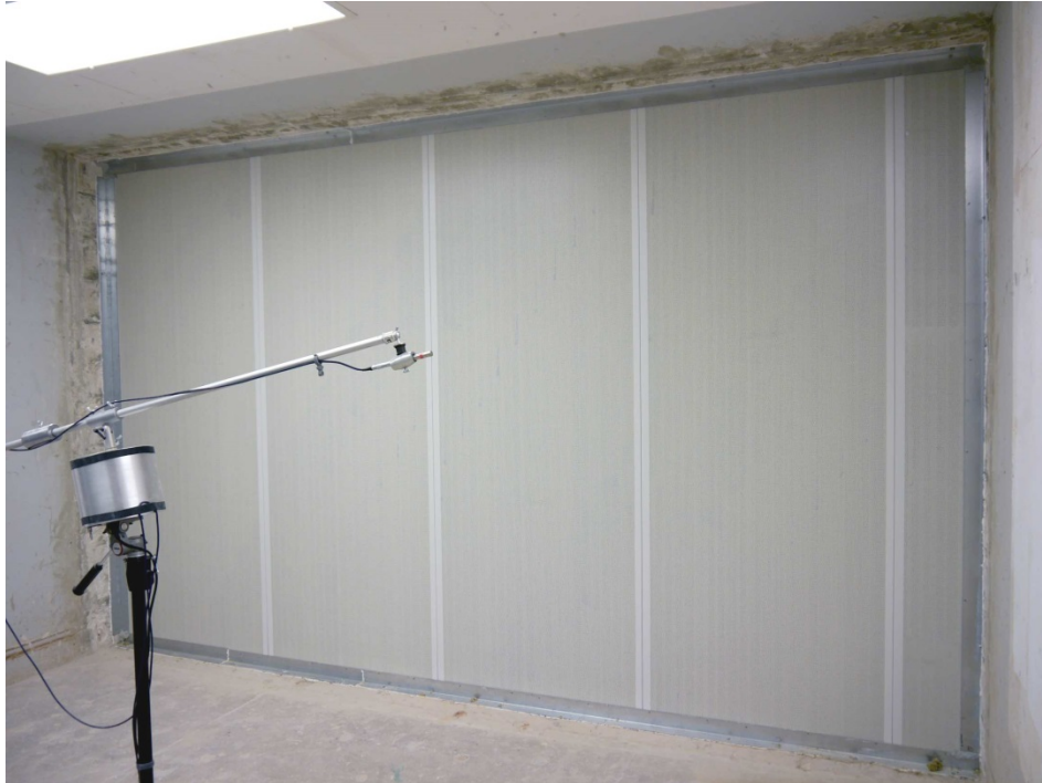
Abbildung 1. Mineralwollpaneele Typ PFLAUM FE-0/AK 100 0,55/0,55 während der Prüfung im Wandprüfstand (senderraumseitig mit Lochung).
