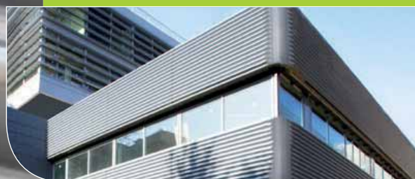
HOPITAL CIVIL Strasbourg (67) - Architecte : C. Vasconi.
